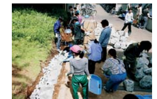
石積みの実習の様子
