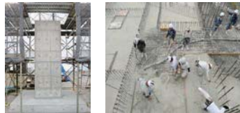
左）実物大模擬柱の施工実験 右）実構造物の施工状況
