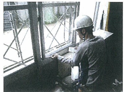
ガラス飛散防止対策工事
