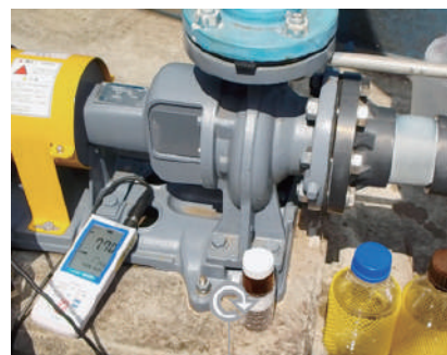
すずかけ台廃水処理施設 (上 全体、下 処理水採水・pH測定)
