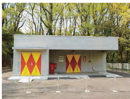
廃液一時保管用危険物倉庫
