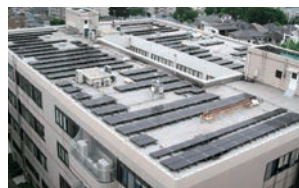
石川台6号館 (101kW)
