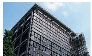
大岡山北3号館 (653kW)
