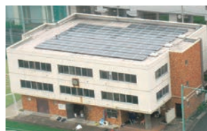
サークル棟4 (34kW)
