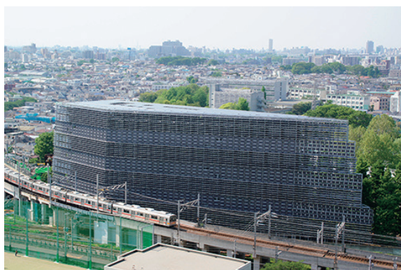
東工大環境エネルギーイノベーション棟の南壁面に設置された太陽電池
