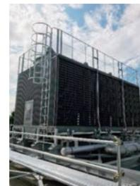
スーパーコンピュータの消費電力は大きく、それに応じた発熱があります。このためしっかりと冷却しなければシステムは安定しません。しかしながらこの冷却にも電力が必要になります。TSUBAME3.0の特徴はこの冷却に必要な消費電力を極限まで低くしている点にあります。冷却システムには、建物の屋上に設置された冷却塔によって生成される冷却水を用いています。この冷却水は夏場で最高32度に達しますが、70度を超えるプロセッサを冷却する用途には十分で、またプロセッサから吸収した熱を大気に放熱することによってわずかな消費電力でこの温度の冷却水を供給し続けることが可能です。
