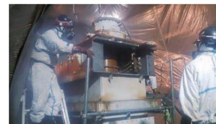
すずかけ台キャンパスにおける低濃度 PCB 混入機器解体の様子（18t）
