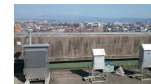
上写真 熊本大学9階屋上に設置した測定機器 後ろにはさすがに阿蘇山が見える
