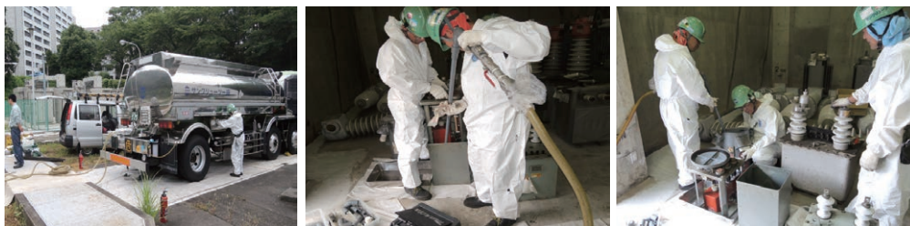
油抜き作業風景
