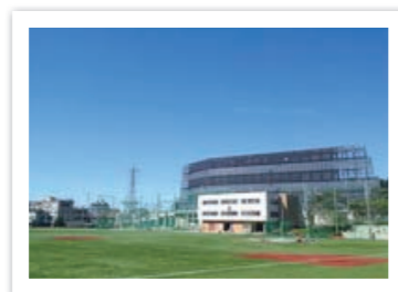
全面人工芝多目的グラウンドとEEI棟
