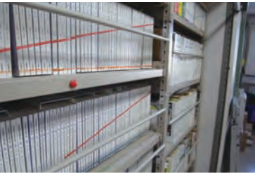
転落防止の施された 雑誌架
