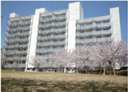
精研・像情報高層棟：改修後
