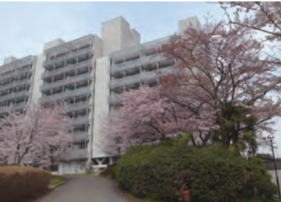
R-2棟の全貌
