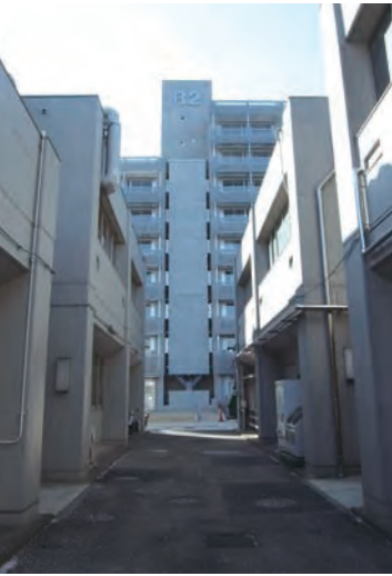
耐震改修後の精密工学研究所 R-2棟（中央）
