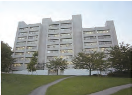
精研・像情報高層棟：改修前
