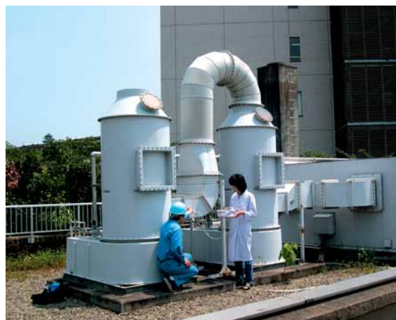
リスクアセスメントに連動させて行っているドラフト排ガス分析
